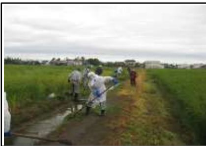
(水路の泥上げ状況)
